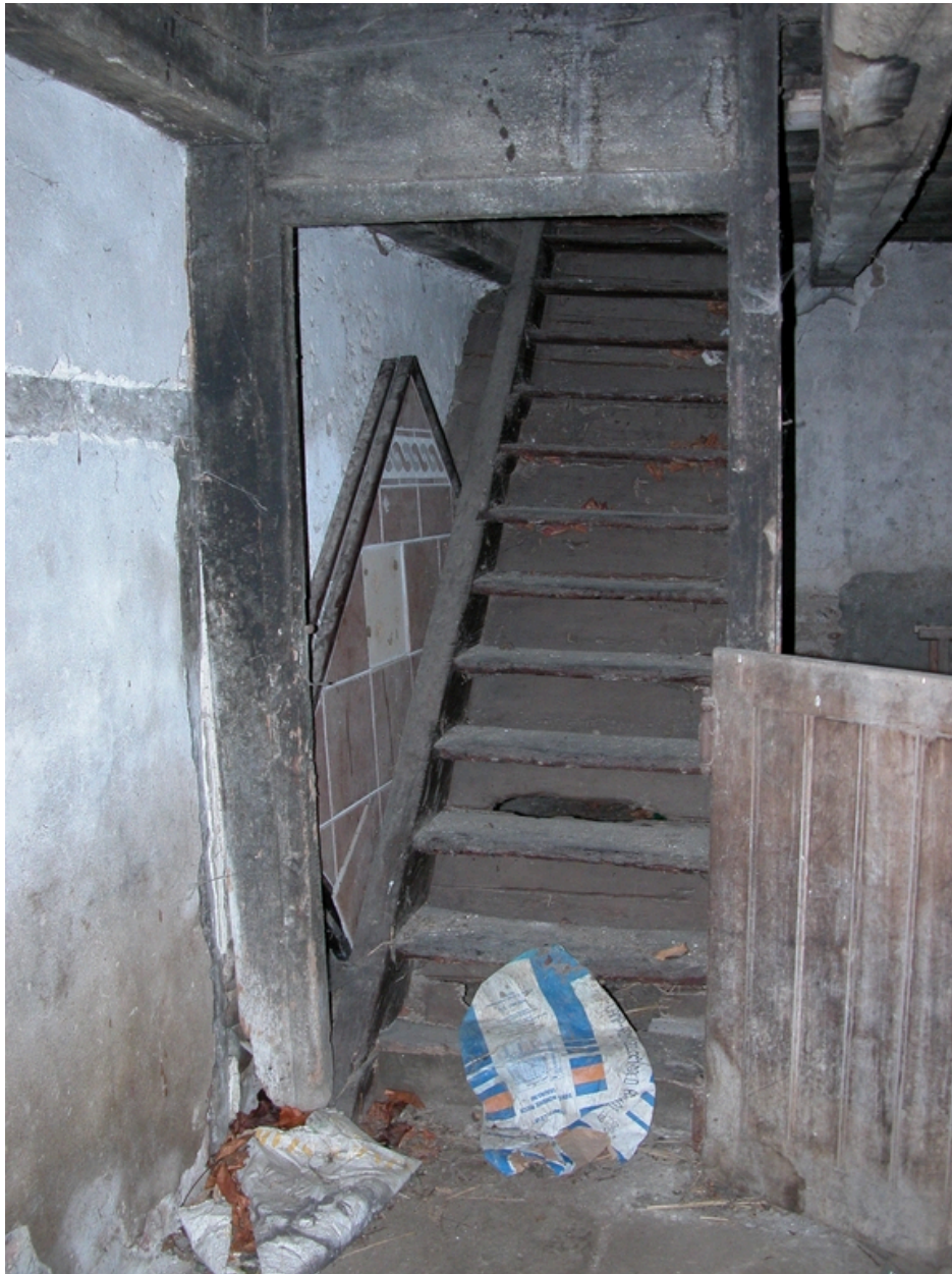
Vue intérieure du logis ancien : escalier.
