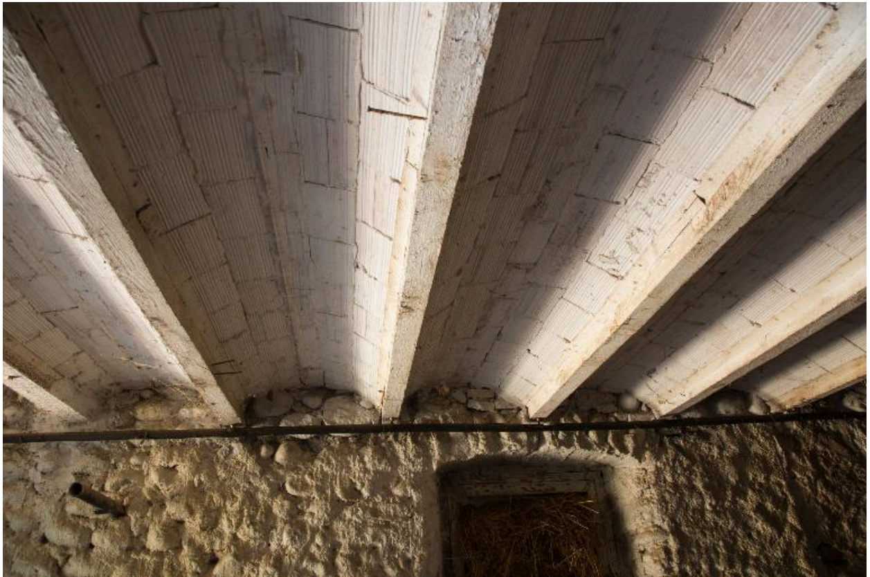
Maison : intérieur, cave côté est. Entrevous en berceau segmentaire
