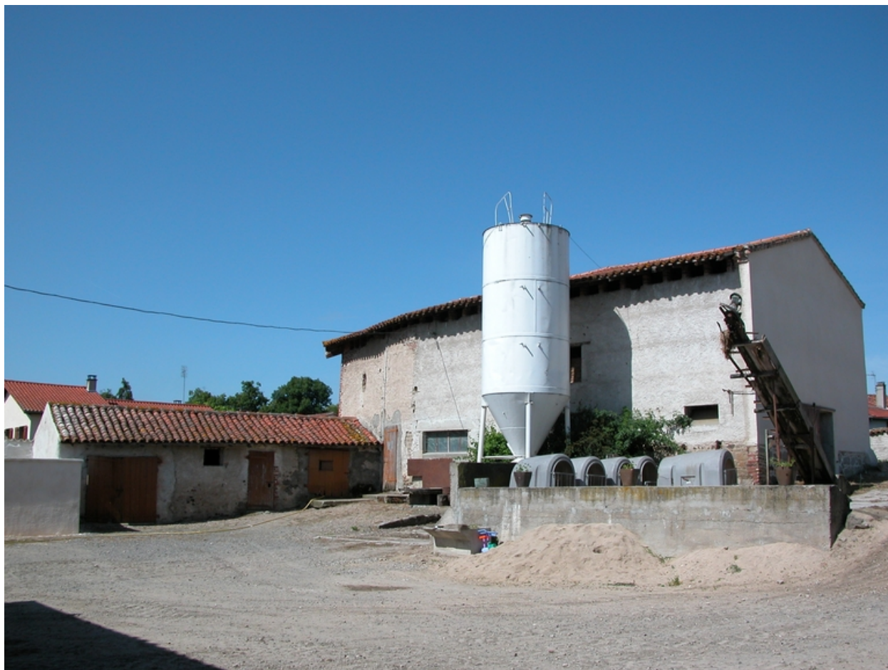
Vue de la grange-étable et des remises de l'angle sud-ouest.
