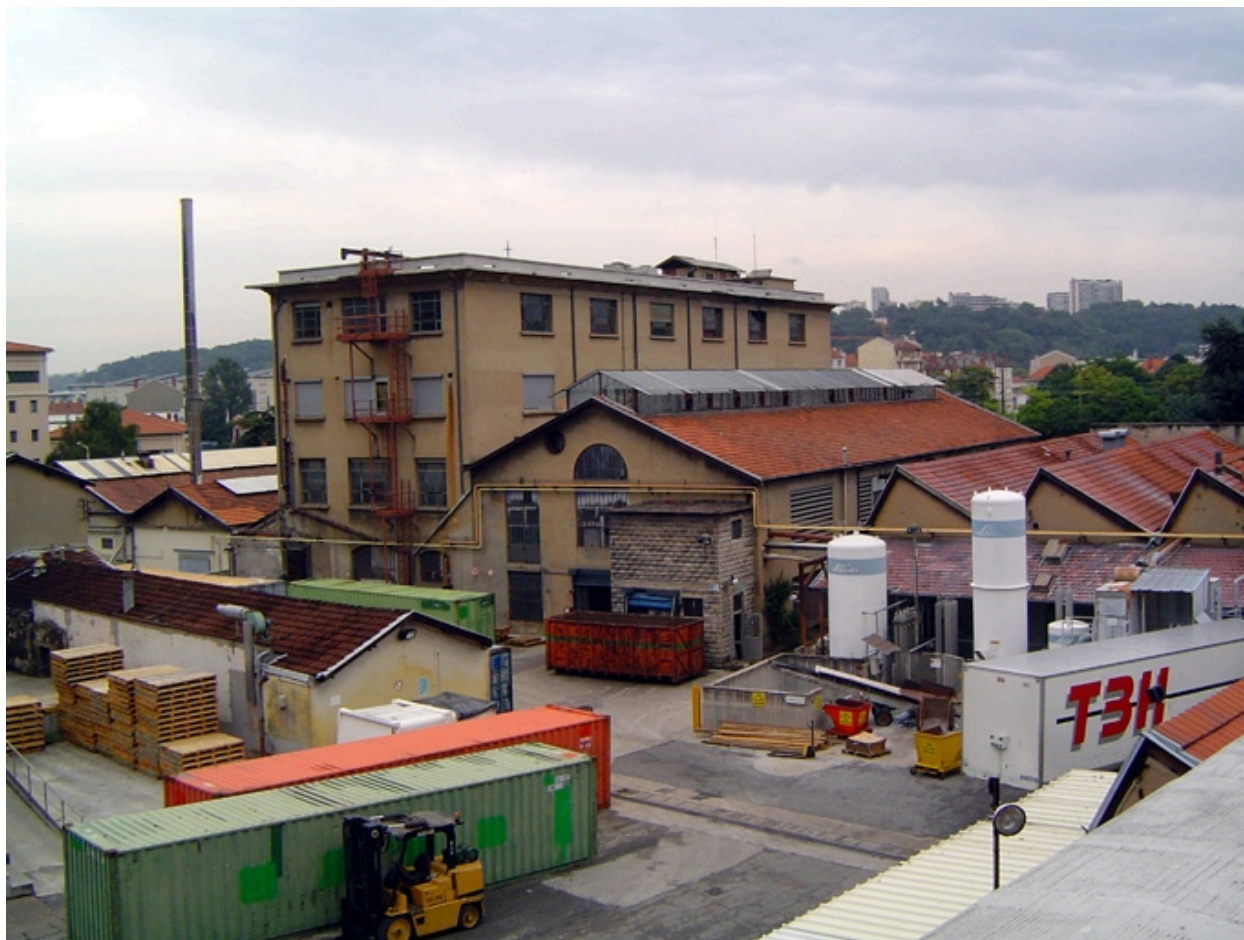
Vue générale ouest
