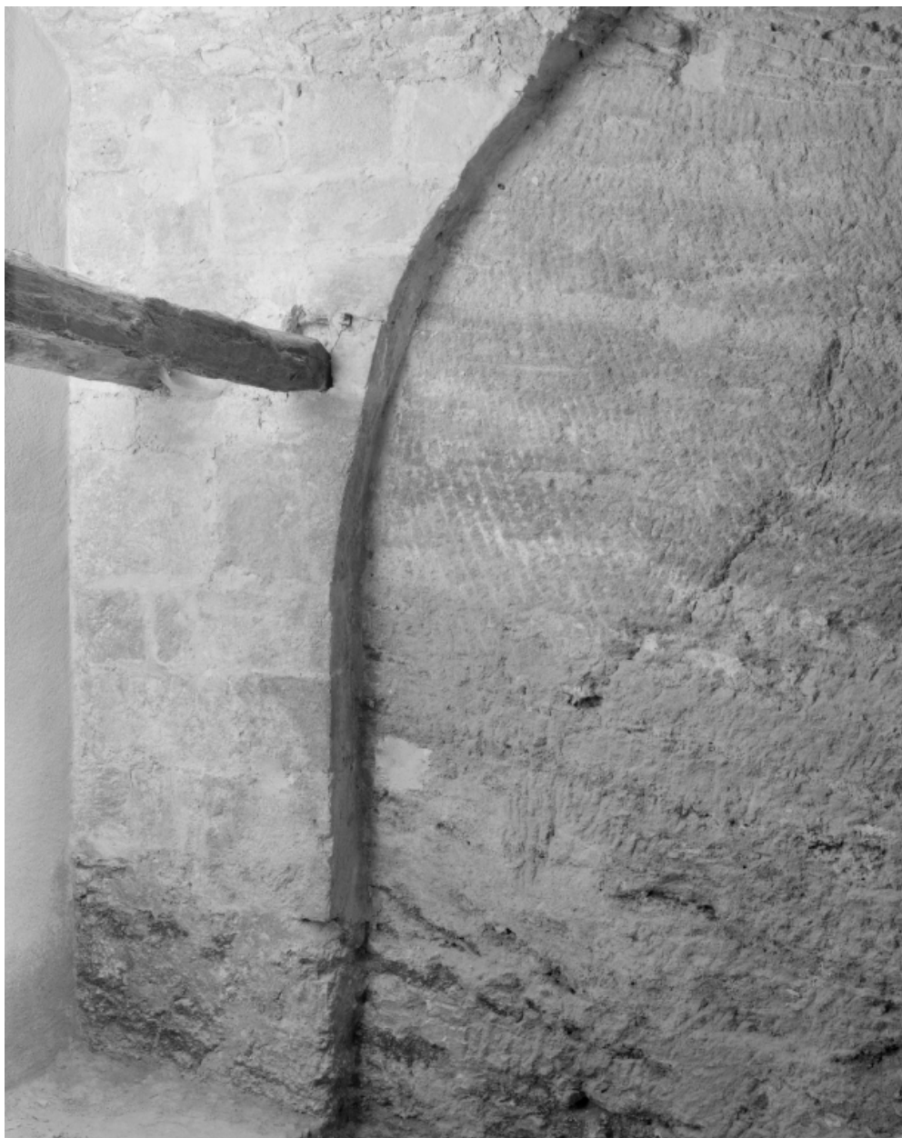
Grande cave. Pénétration de la porte d'accès dans la voûte. Vestige de l'appareil.
