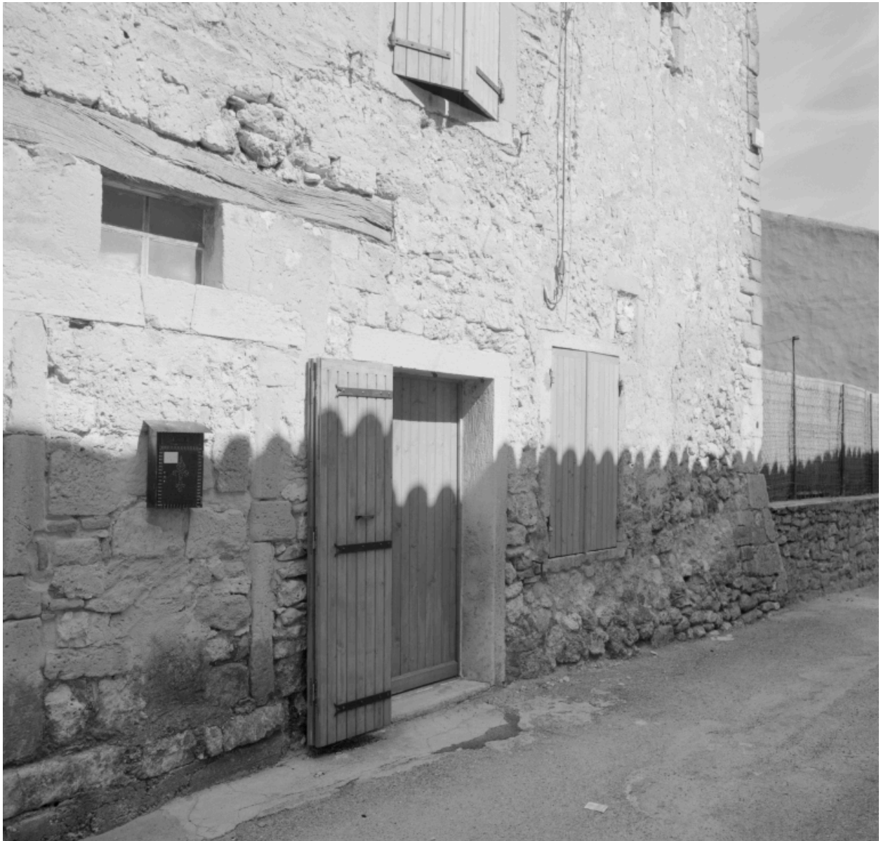
Maison (A 714), Grande rue, côté pair. Vue partielle du 1er niveau.
