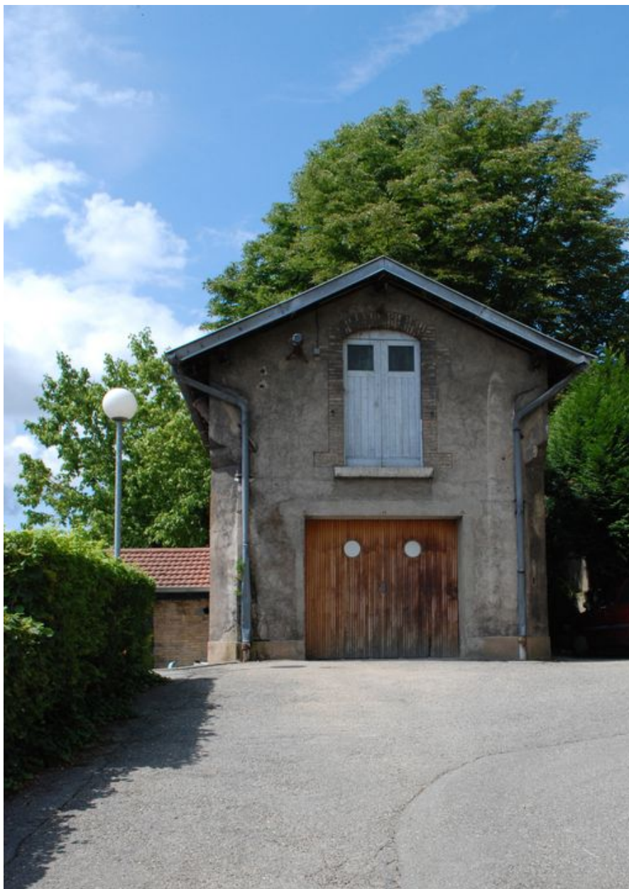
Elévation nord-est du bâtiment à usage actuel de garage, devant être détruit.
