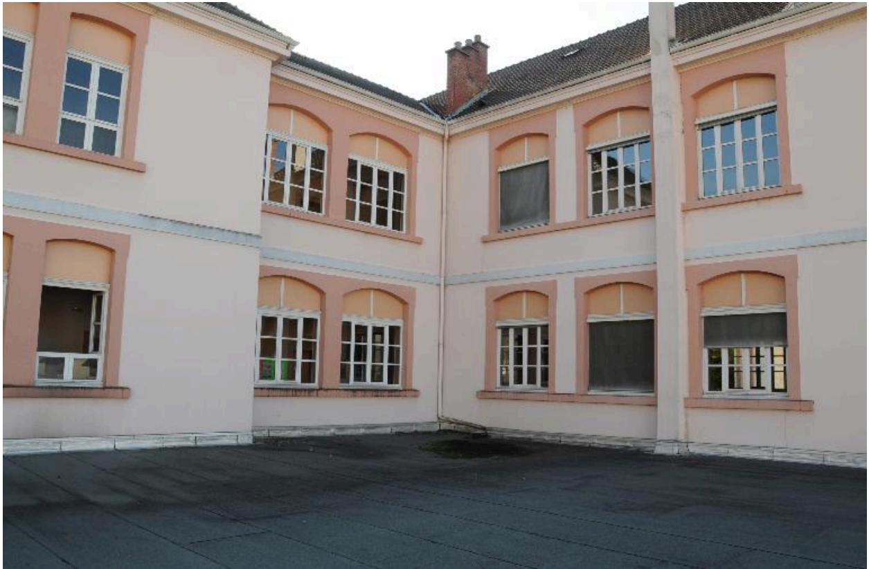
Baies des 1er et 2nd étages
