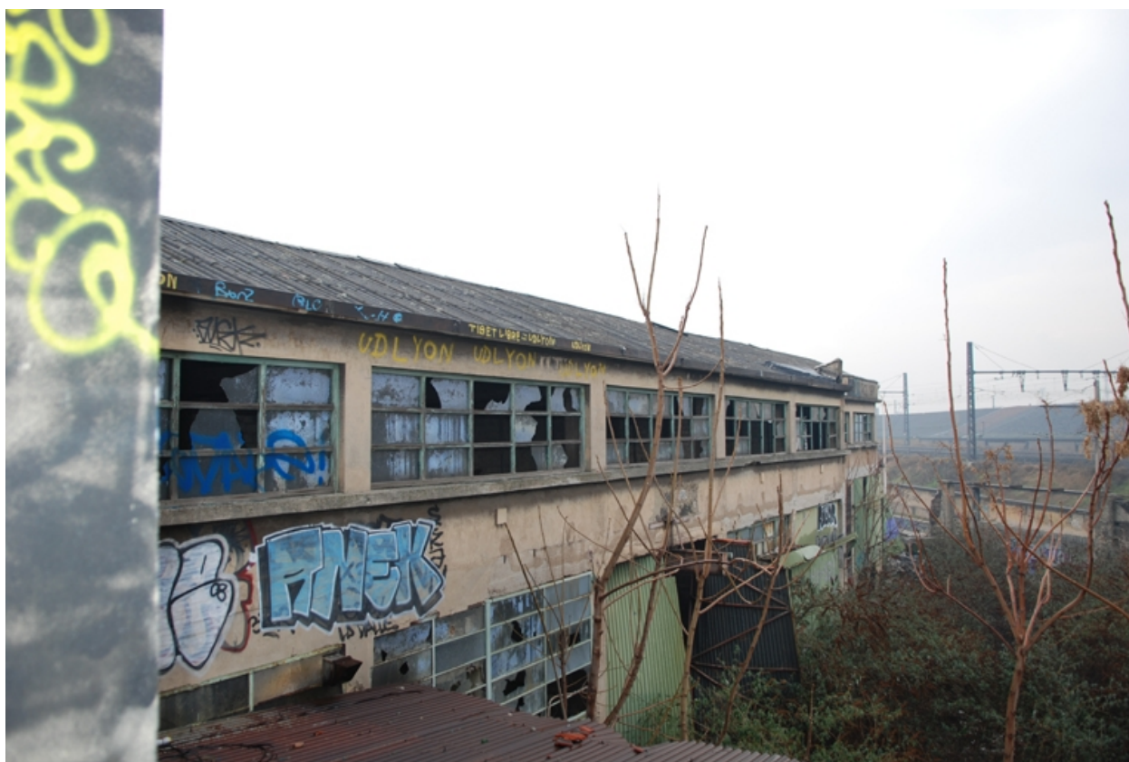
Façade vue sud-est
