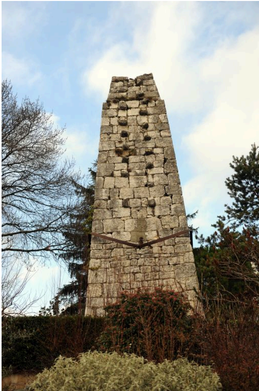
Pile subsistante en rive droite, vue générale
