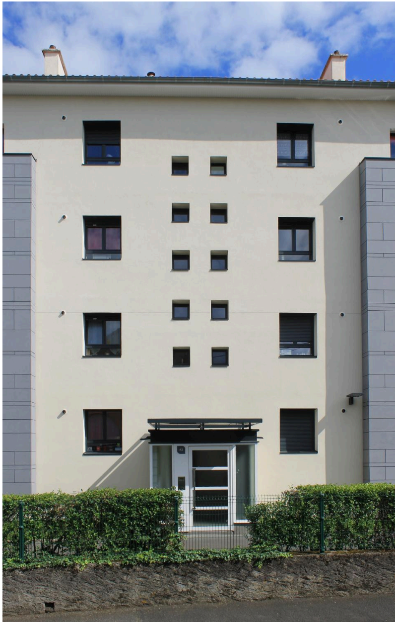
Riom, la cité HLM de la route de Marsat, détail de la façade nord-ouest du bâtiment A.
