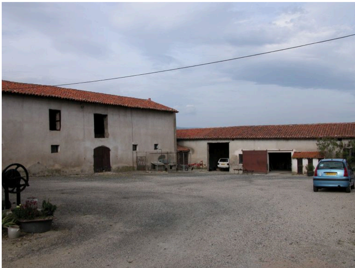
Angle nord-ouest de la ferme (étable - fenil et communs)
