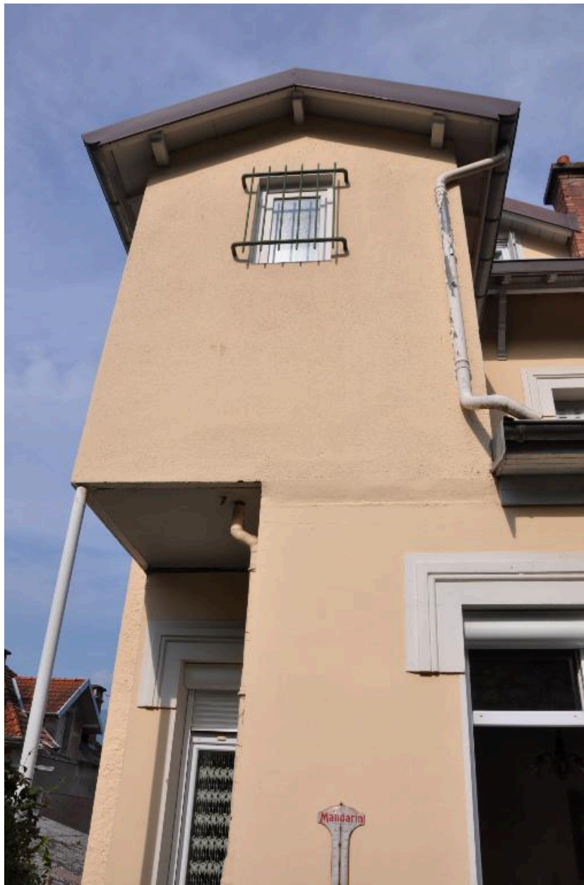
Logette sur l'élévation orientale
