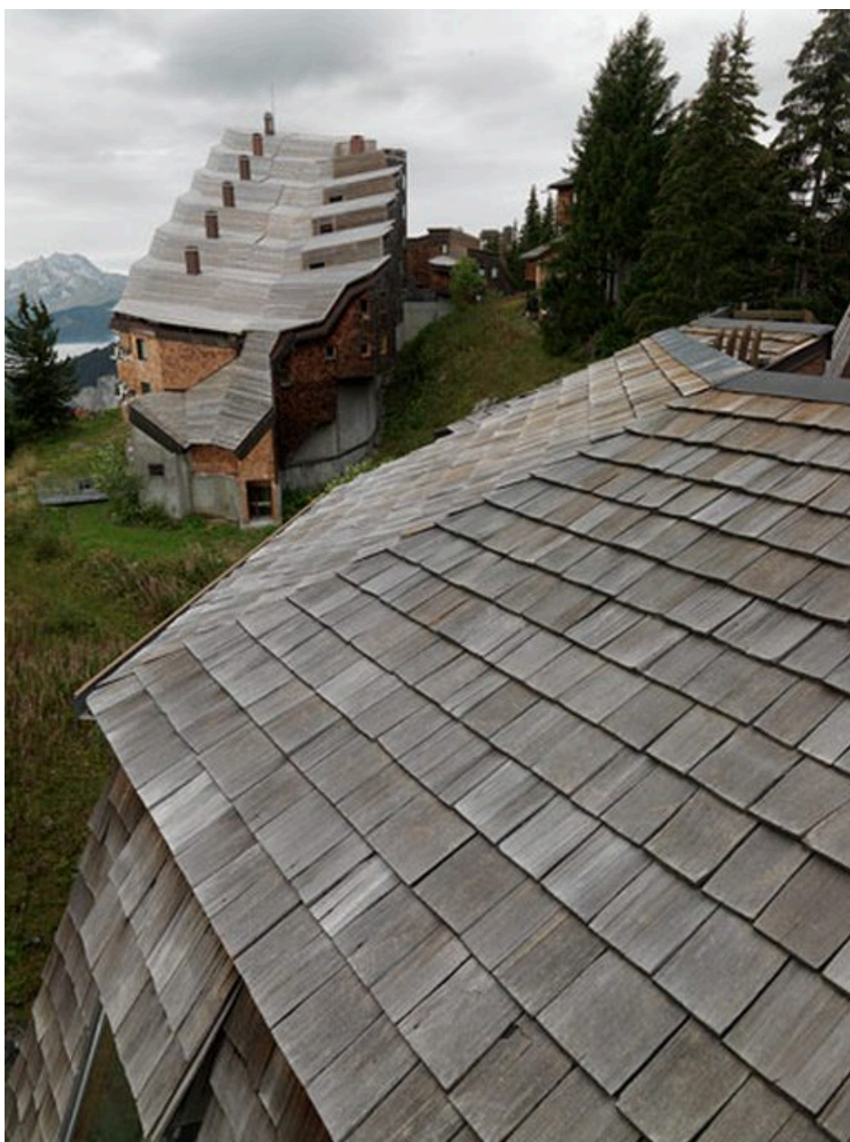
Vue d'ensemble de la toiture depuis le Sosna
