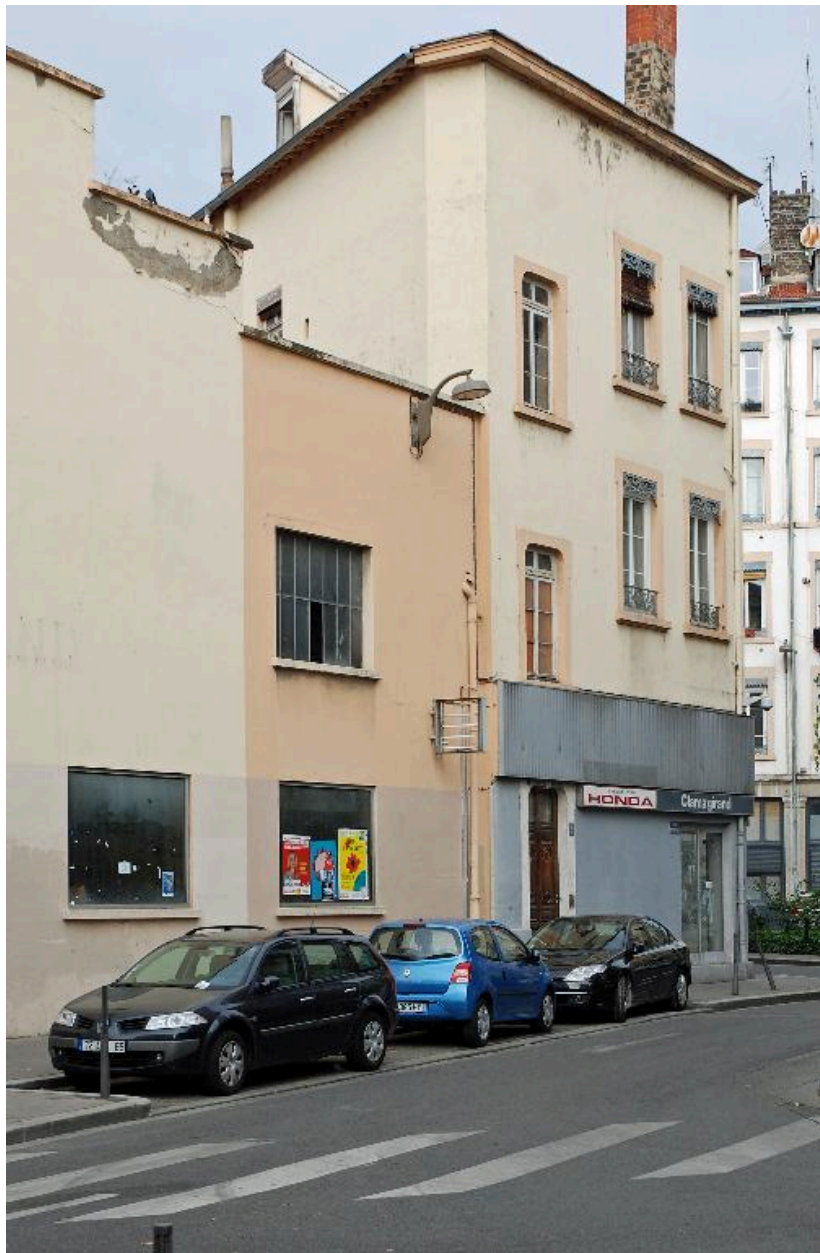
Elévation latérale, sur la rue Béchevelin
