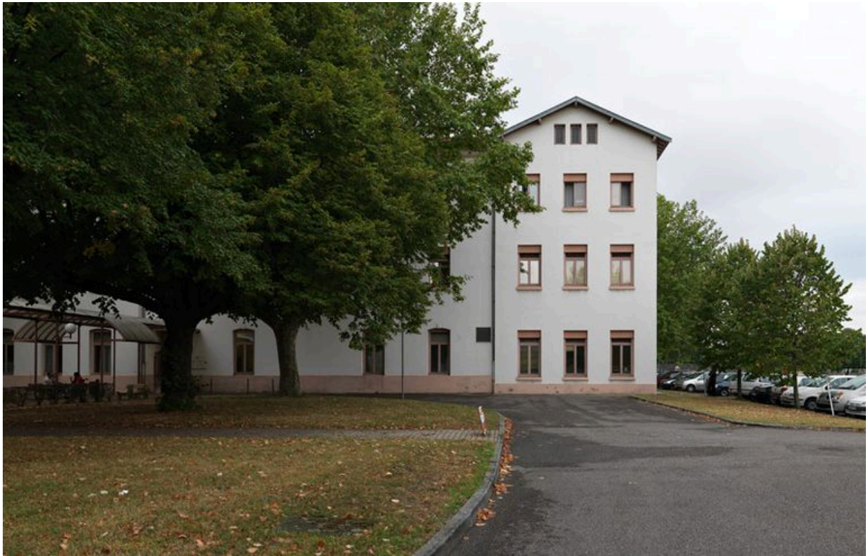
Bâtiment ouest, façade principale (est)
