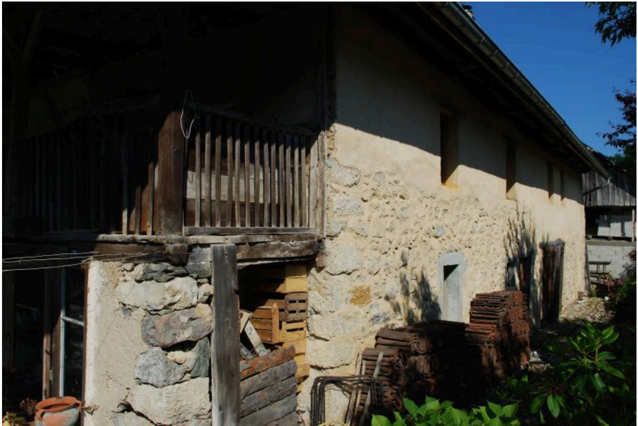
Bâtiment principal, façade postérieure.
