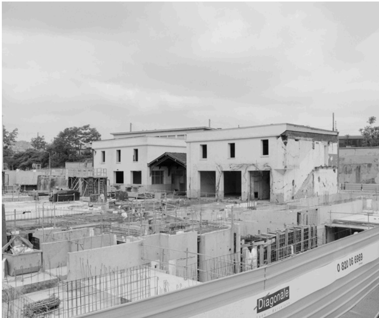
Vue sud-est des deux pavillons d'entrée qui sont conservés
