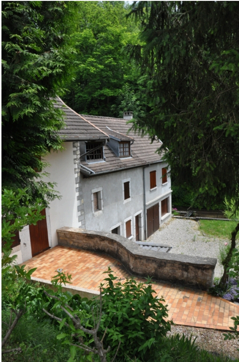
Vue générale, façade sud
