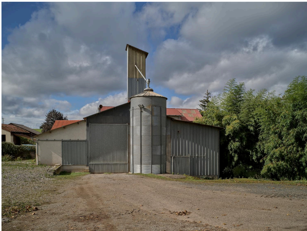
Vue occidentale du moulin.
