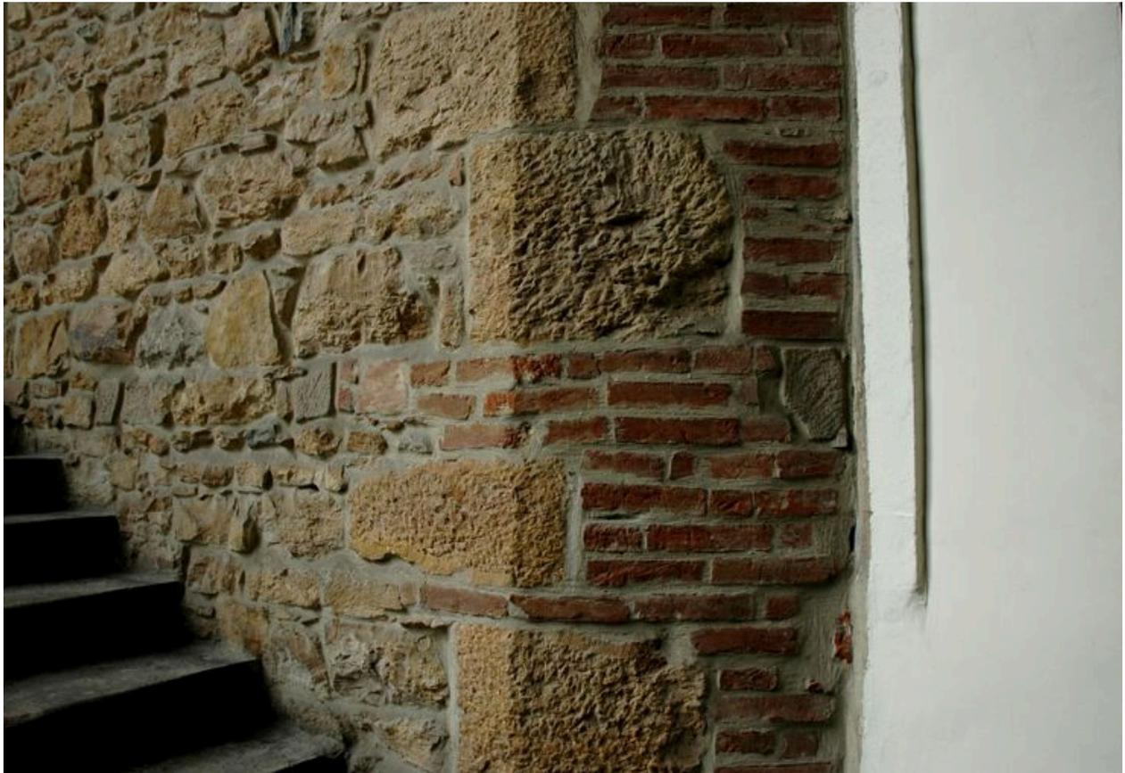
Chaînage d'angle en briques et calcaire du montant droit des portes ouvrant sur l'escalier extérieur depuis la cage d'escalier principale
