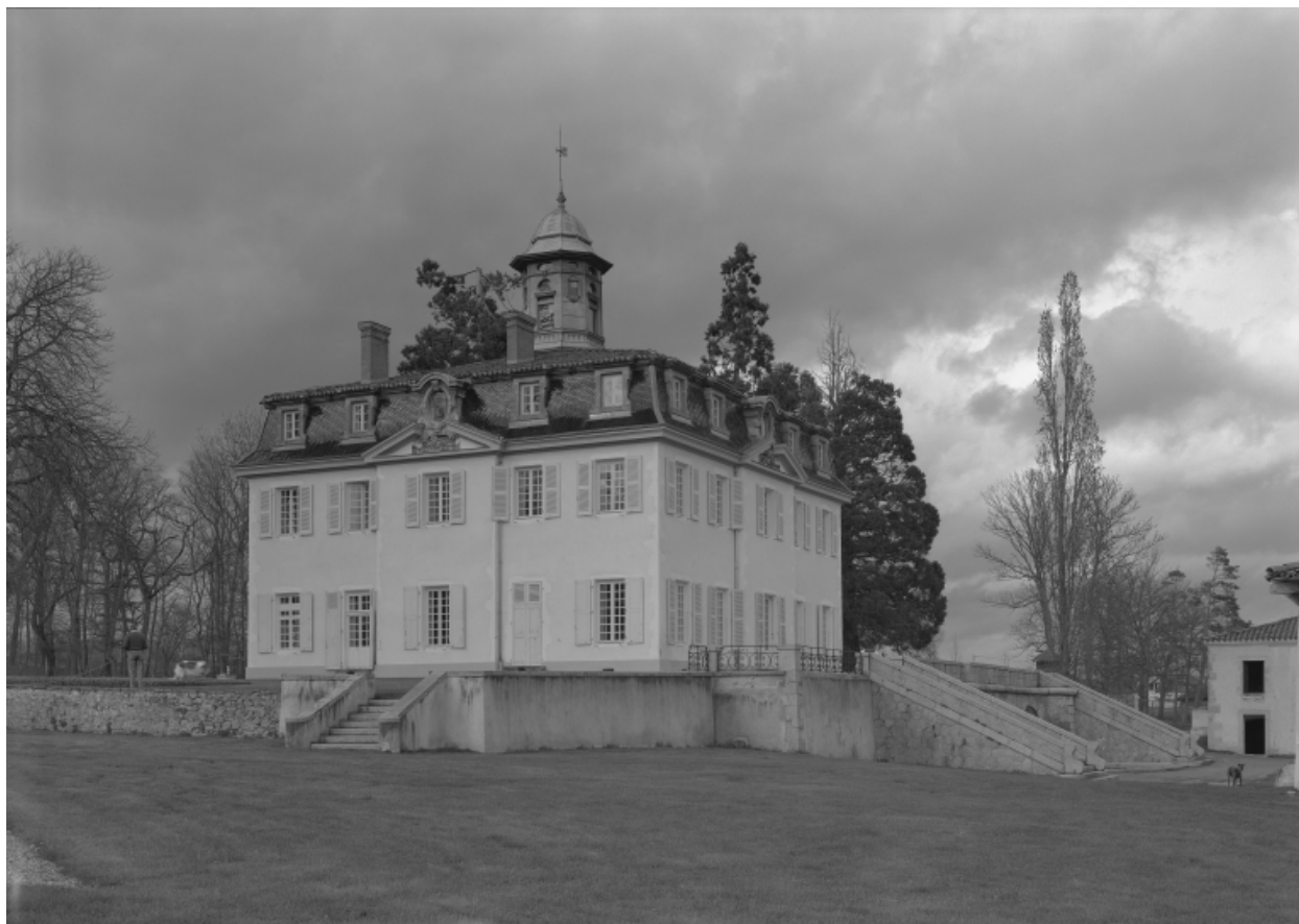
Vue générale du château, du sud-est.
