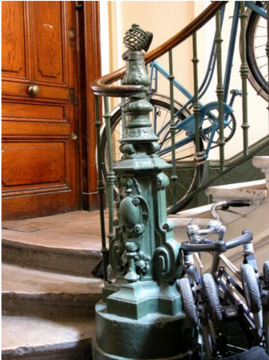
Escalier, départ de rampe
