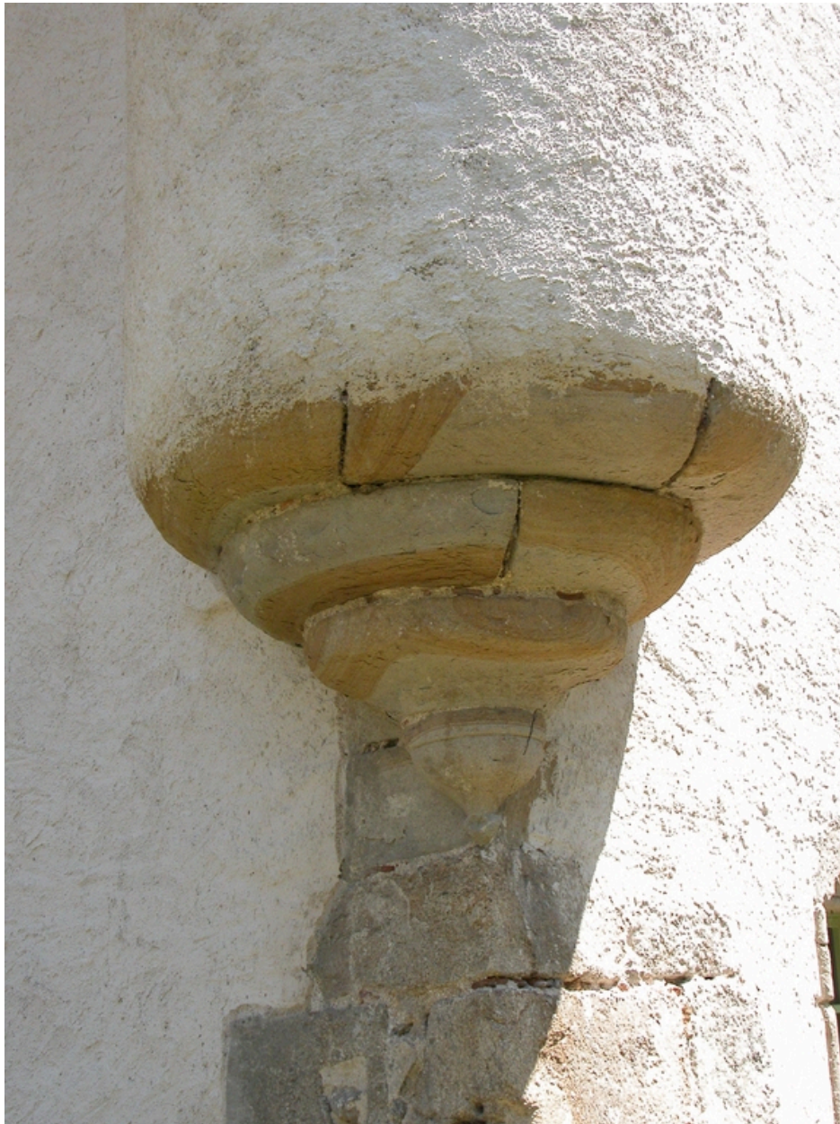
Vue du culot d'une tourelle en surplomb.
