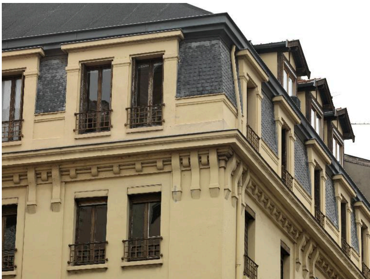
Détail de la corniche et de l'étage de comble, angle sud-ouest
