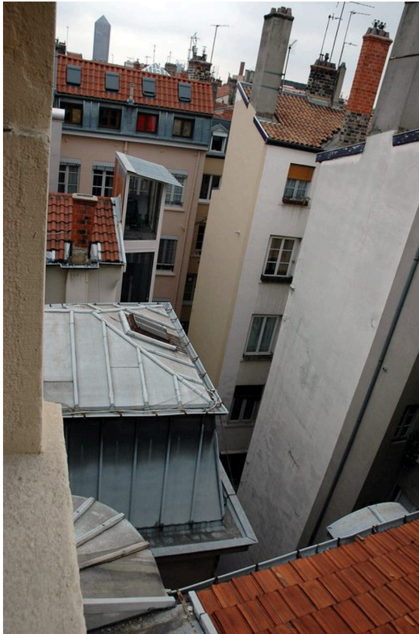
La couverture de la cage d'escalier depuis l'immeuble sis 33 rue de Brest
