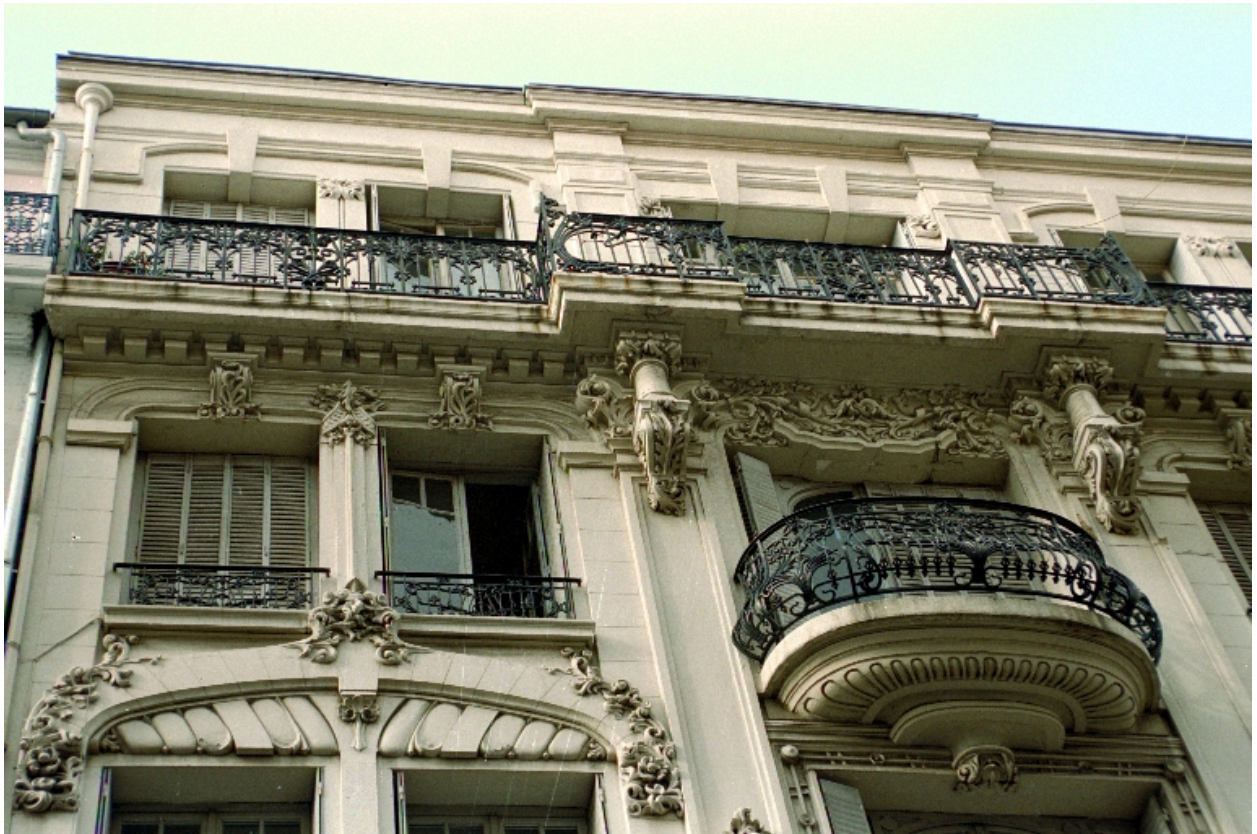
Façade principale. Détail des niveaux supérieurs
