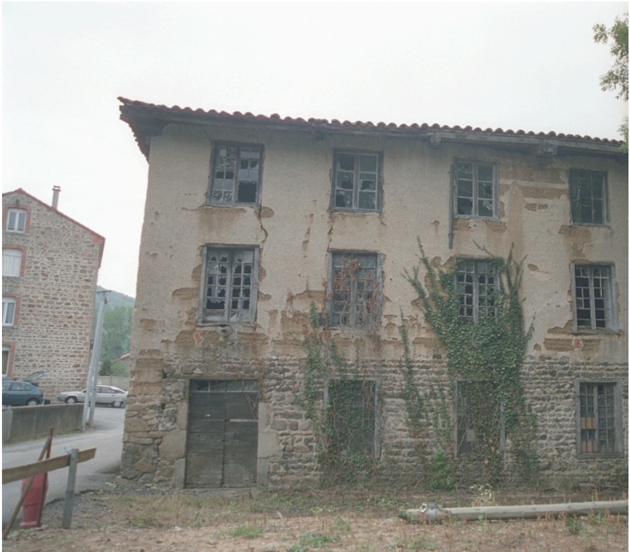
Vue partielle de face avant
