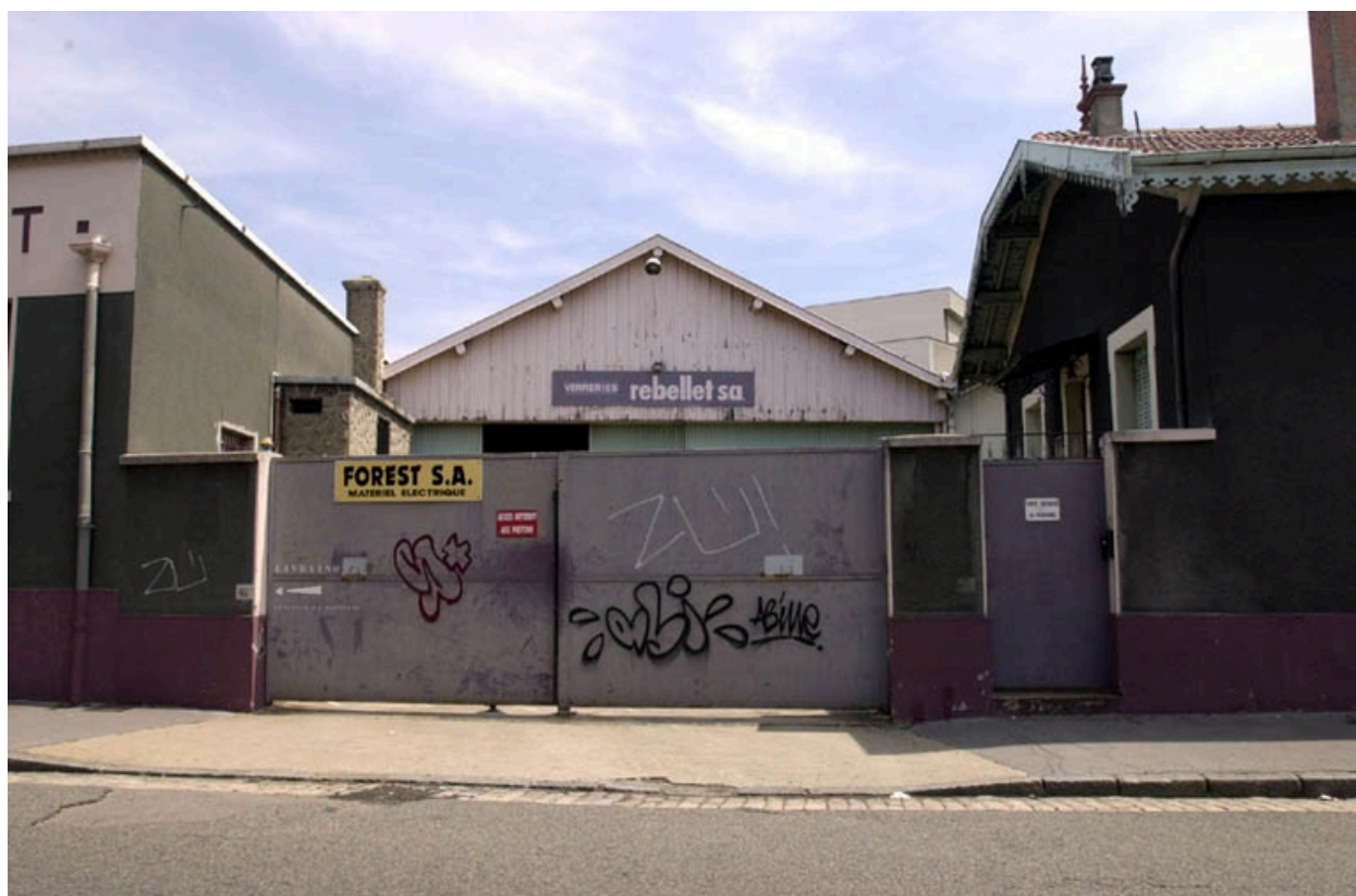
Entrée marchandise, à l'arrière toiture en bois de l'extention de 1950, couverture d la cour
