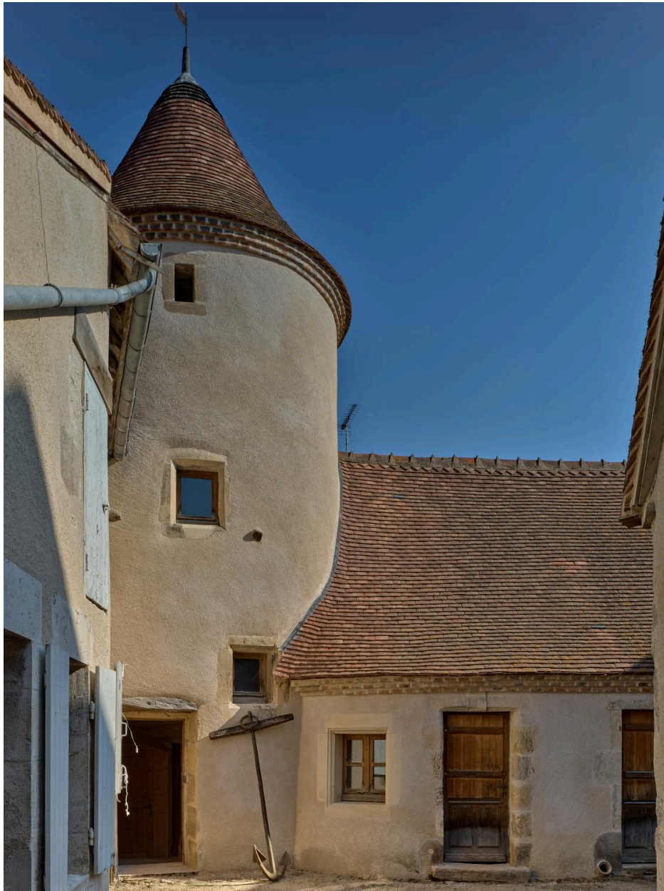
Vue de détail de la façade méridionale du bâtiment côté cour après restauration.
