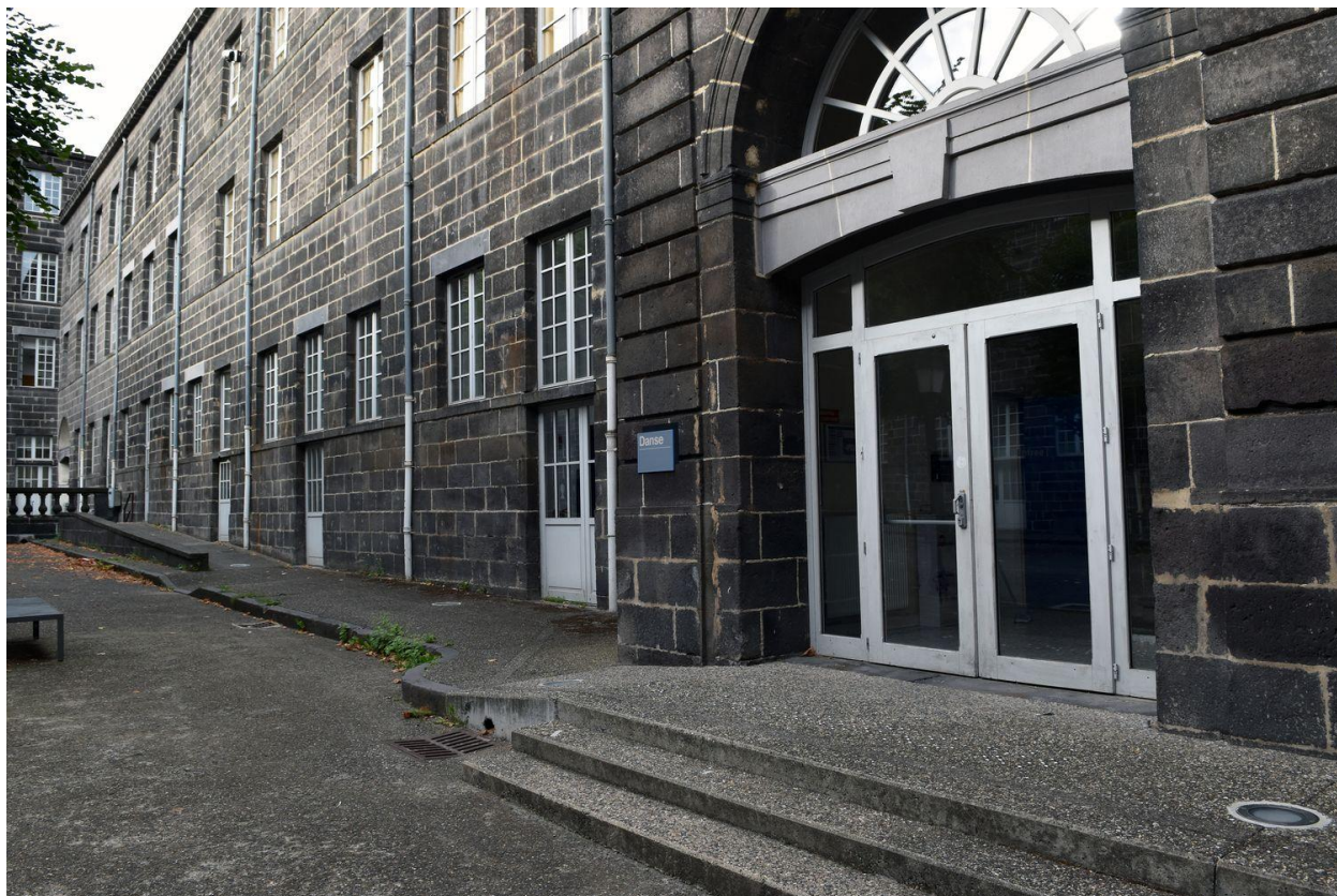
Bâtiment B : vue partielle de l'élévation sur cour depuis le nord
