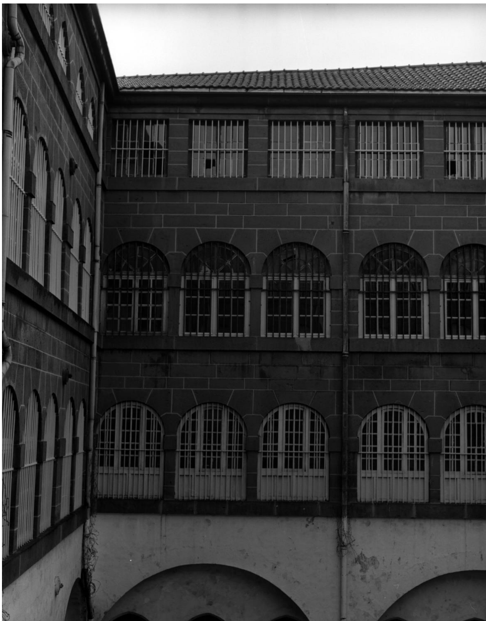
Cloître, élévation ouest. Cinq premières travées à partir du sud.
