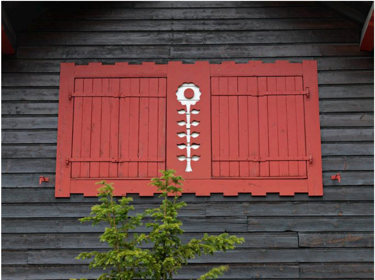
Chalet les Sorbiers, 373 route du Bouchet, construit en 1950. Une fenêtre et son volet
