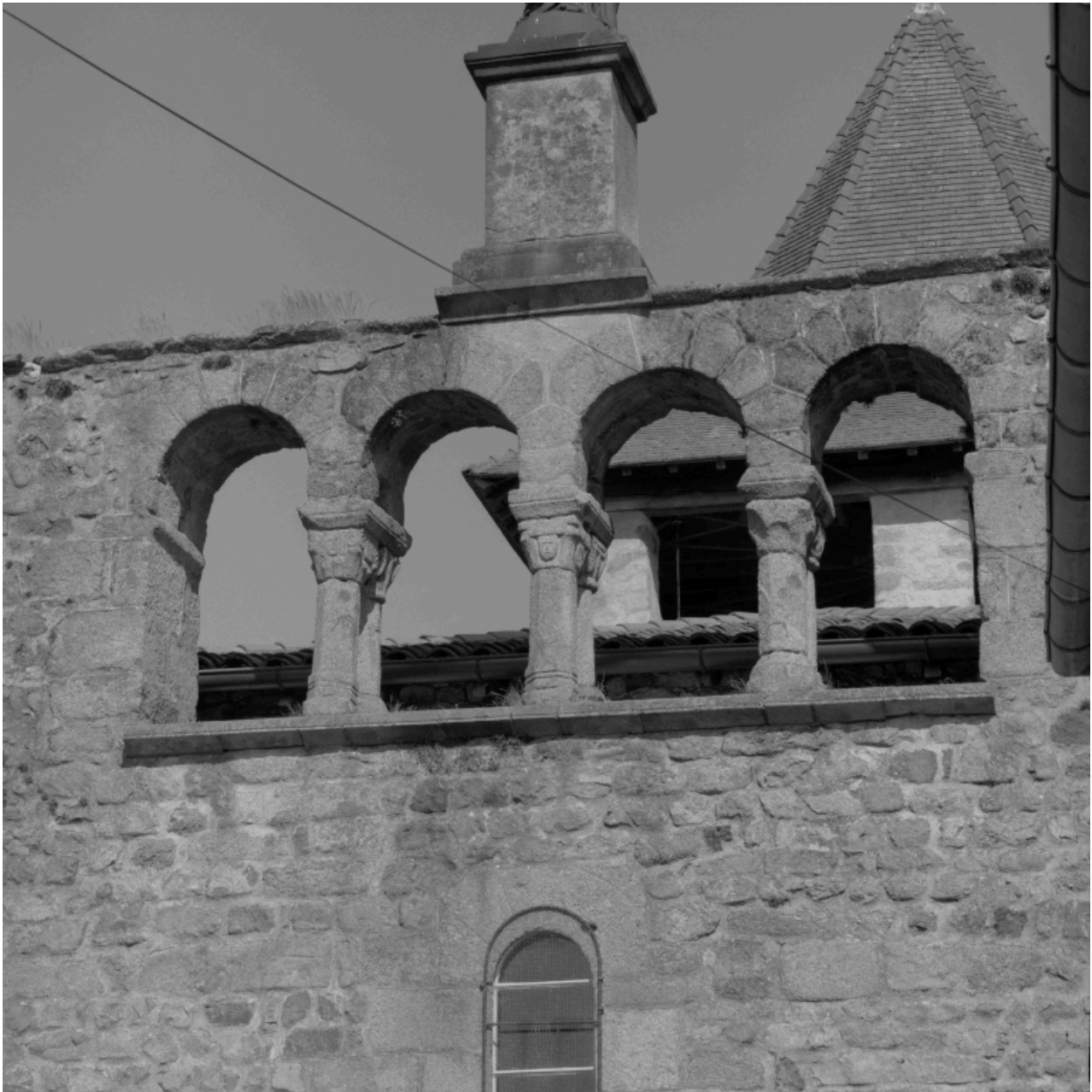
Façade occidentale, détail du clocher-mur.
