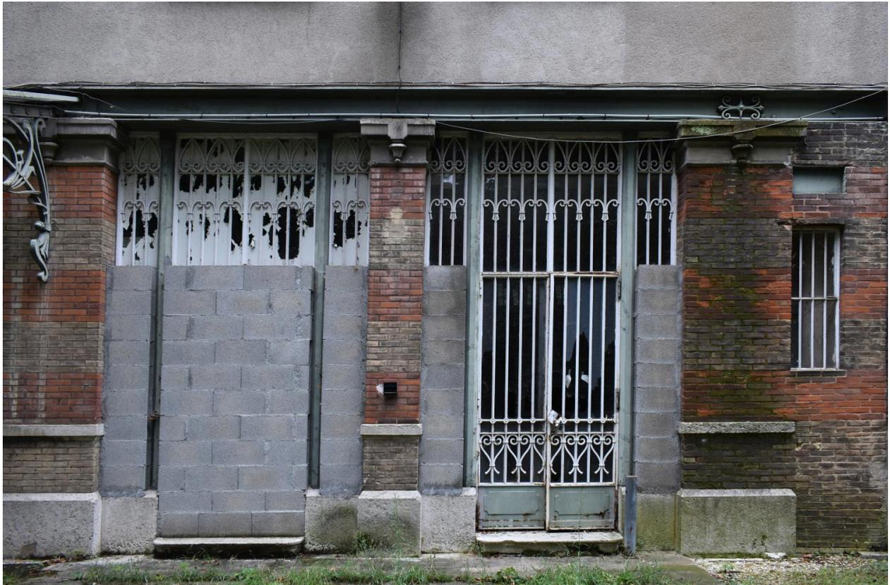
Élévation antérieure : portes de l'entrée principale, linteau ipn supporté par des piliers en brique avec chapiteaux en pierre de taille
