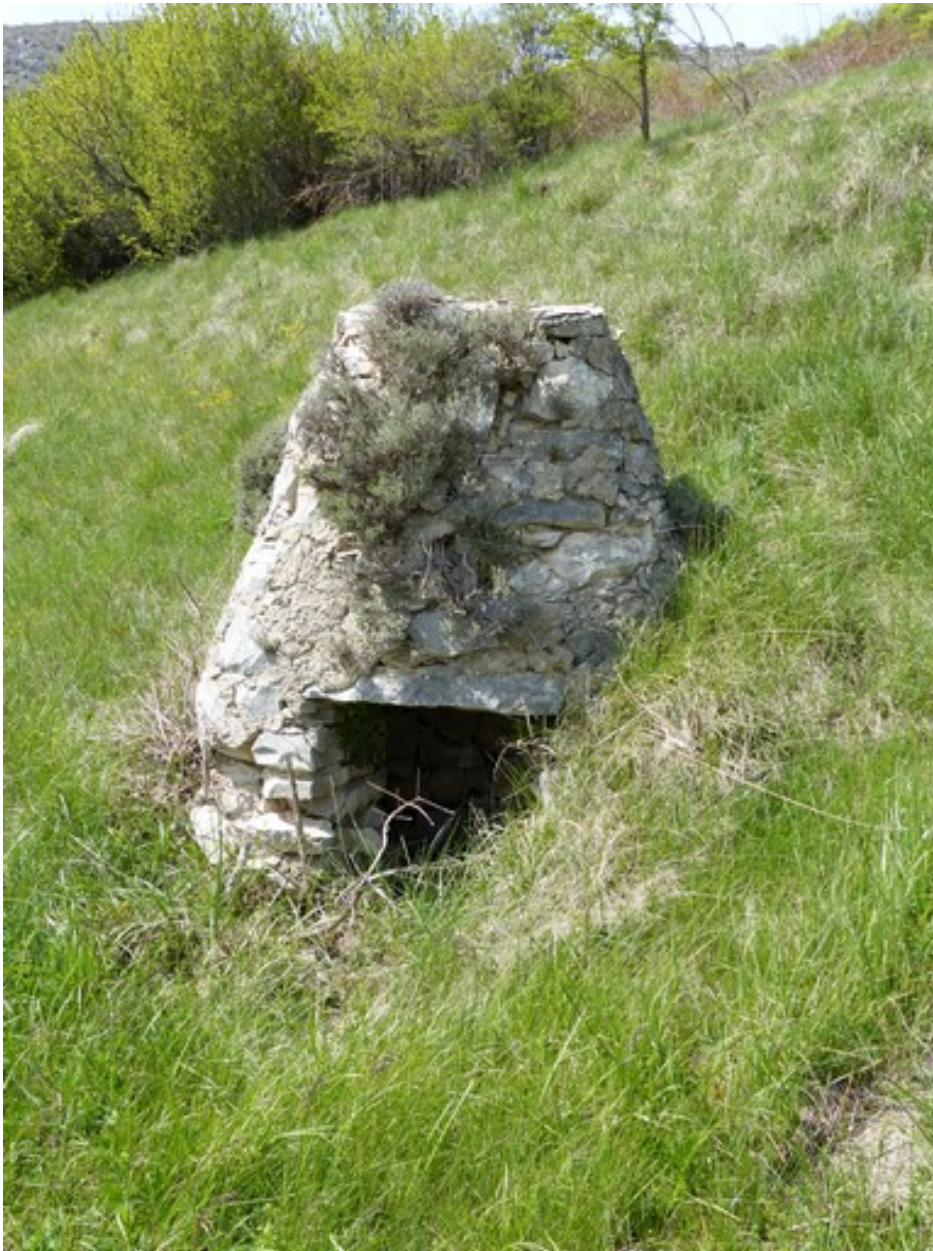
Vue d'ensemble prise de l'est.
