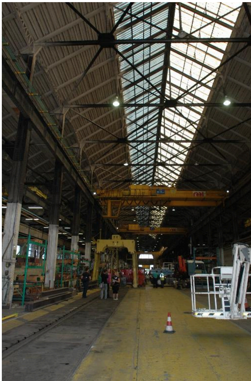
Vue intérieure des ateliers charpente métallique
