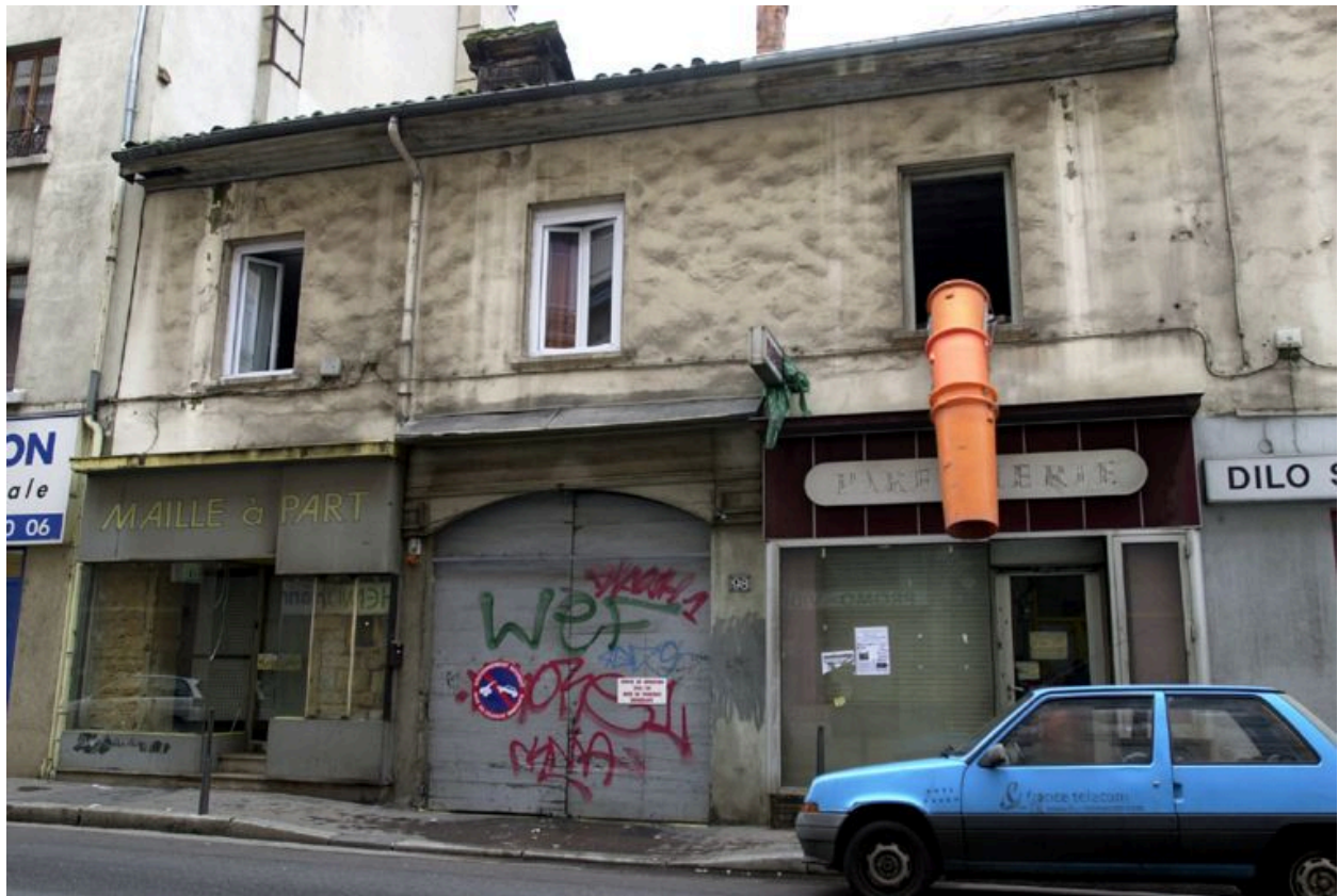
Élévation, 98 grande rue de la Guillotière
