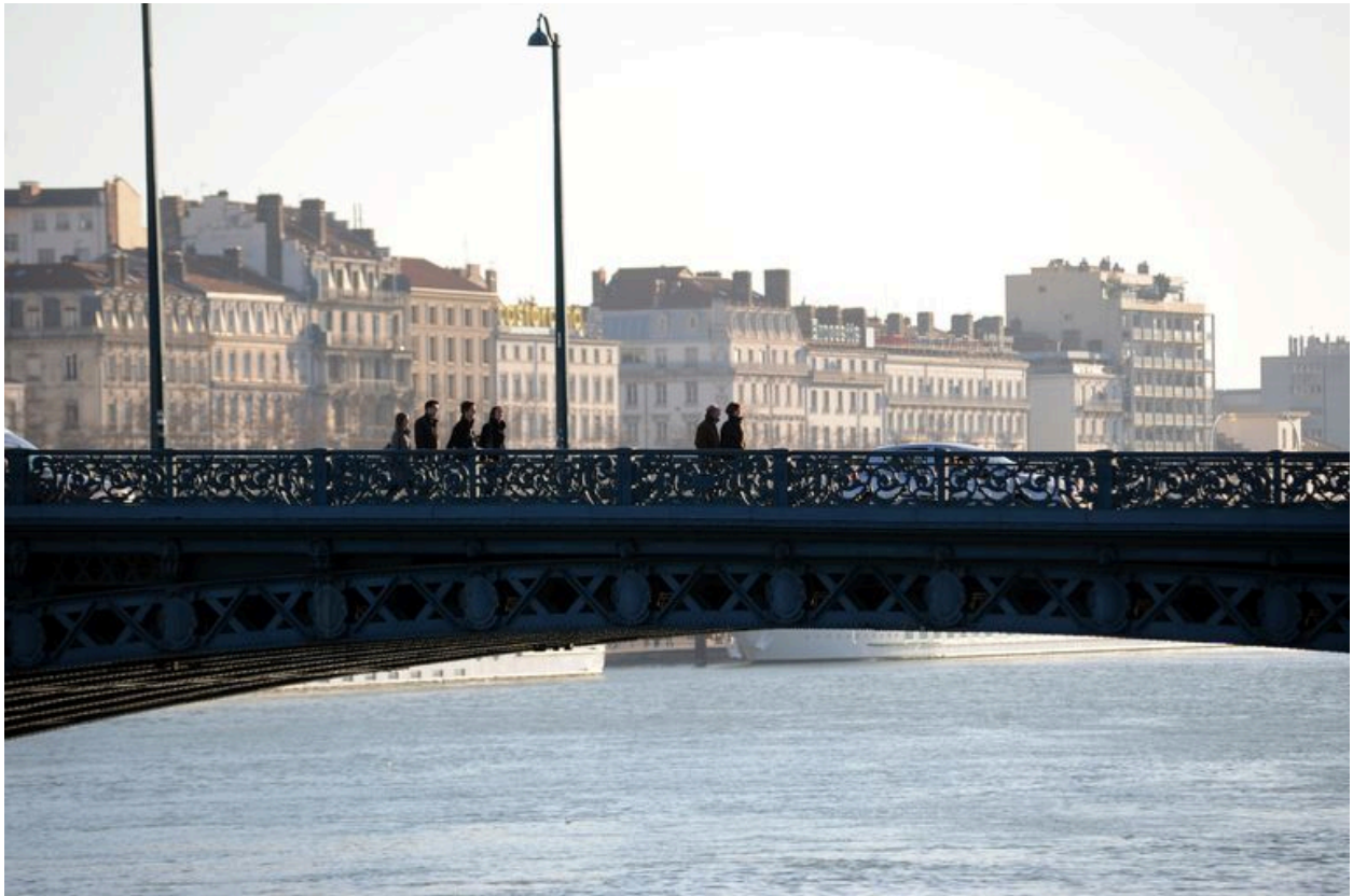
Arche, face amont, vue partielle : décors de la partie centrale et balustrade (depuis la rive droite)
