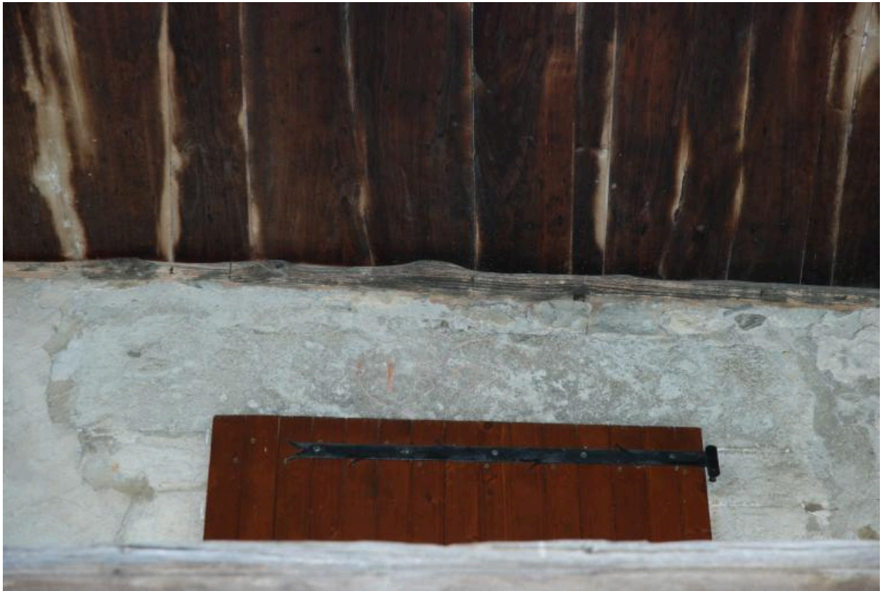
Détail de la partie habitation : Linteau de la porte du logis daté 1828.
