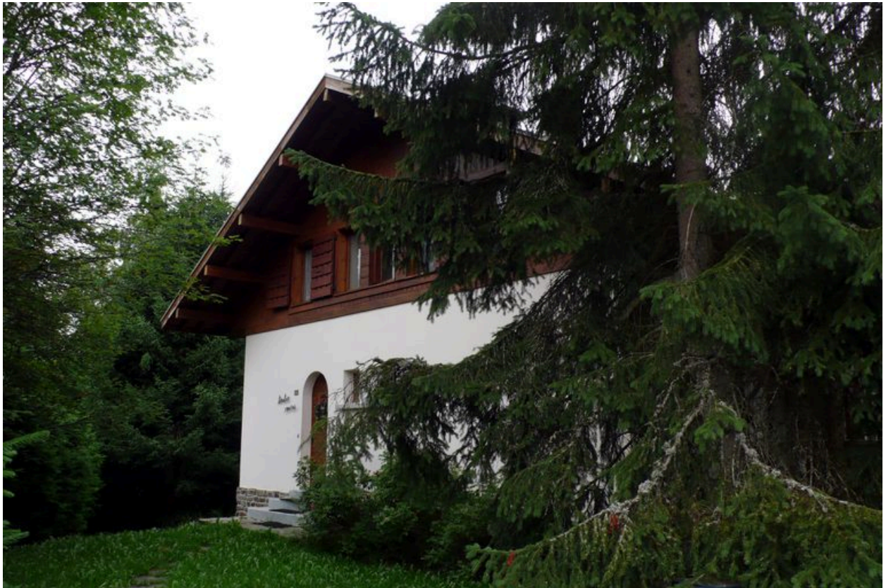
Chalet Toutes Aures, 146 route des Pettoreaux, construit pour Louis Marchal en 1955
