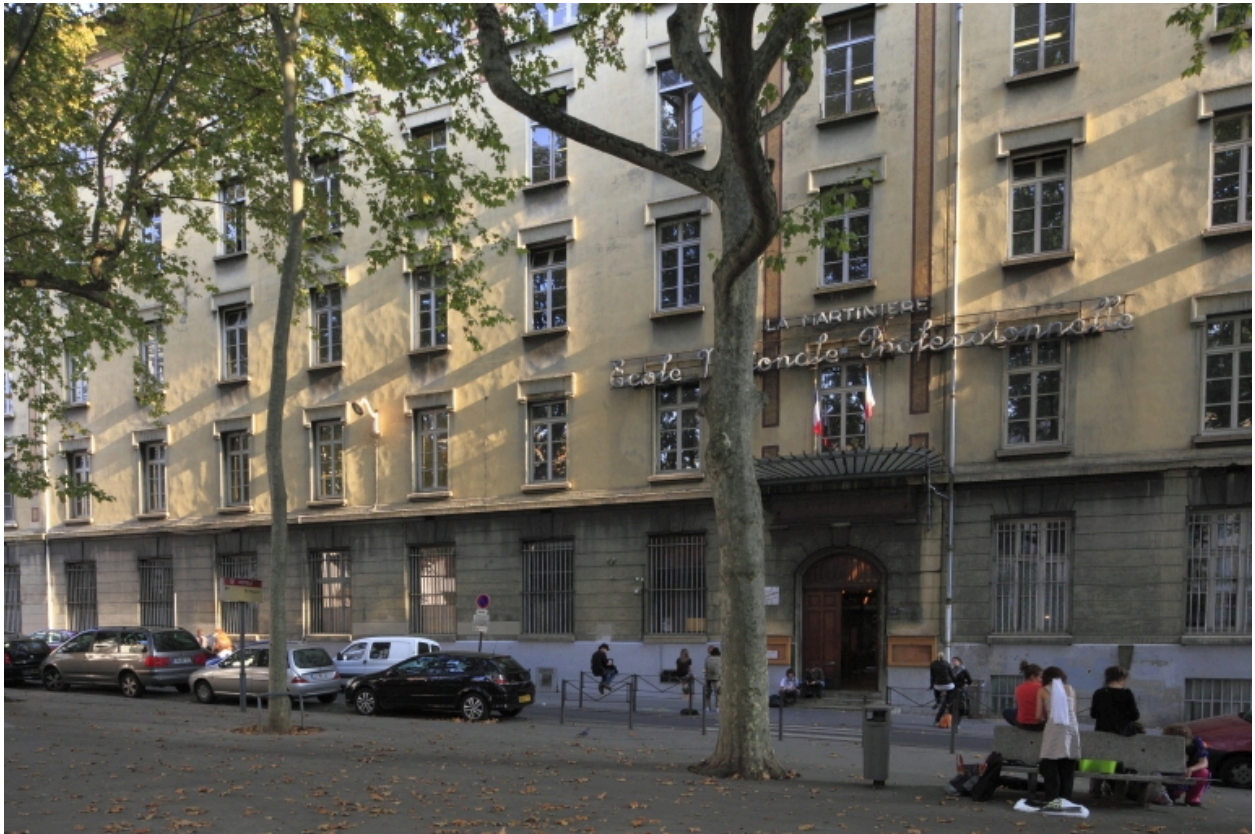
Façade principale, place Gabriel-Rambaud. Vue partielle.
