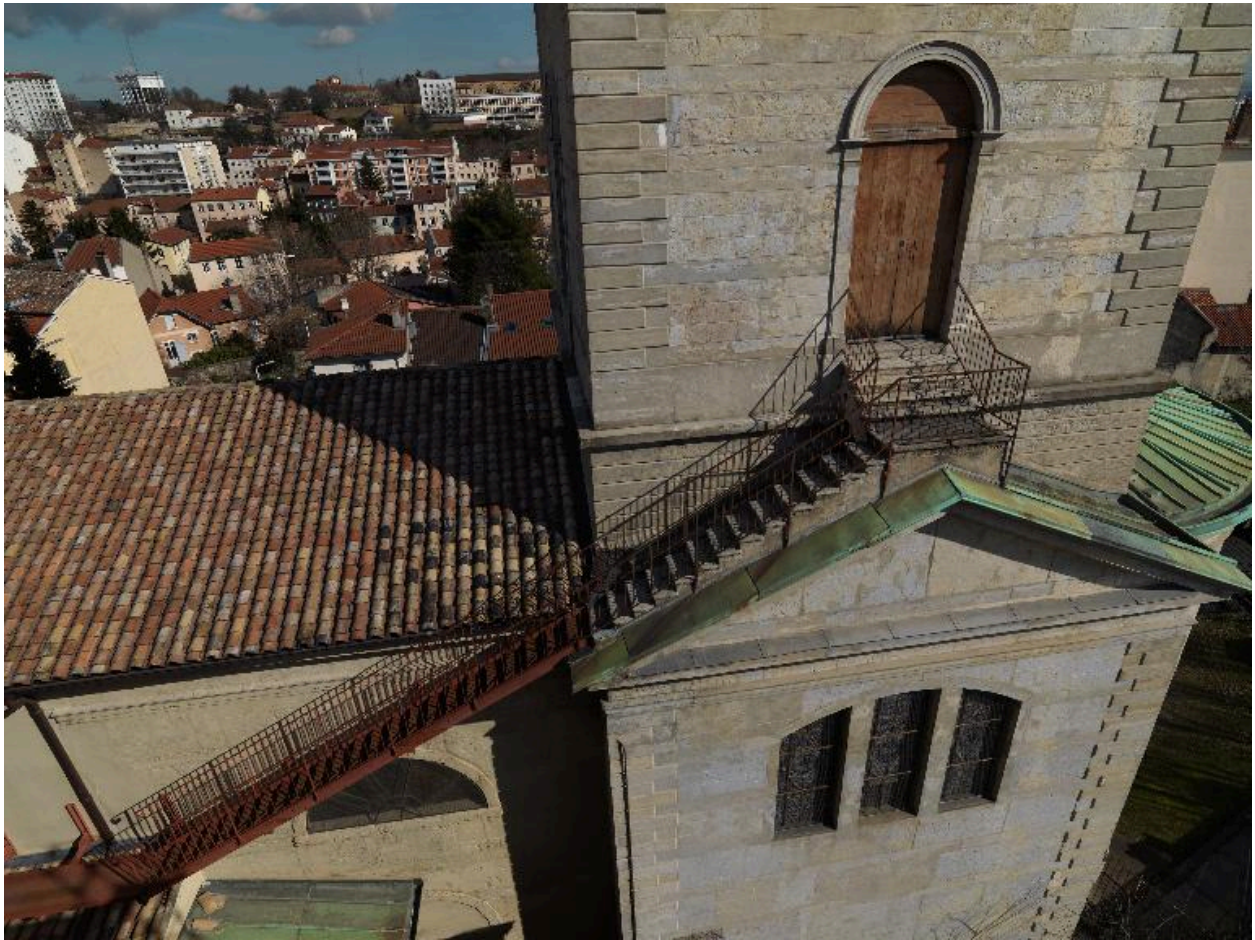
Elévation est, vue partielle depuis le toit de l'ancien prieuré des Génovéfains
