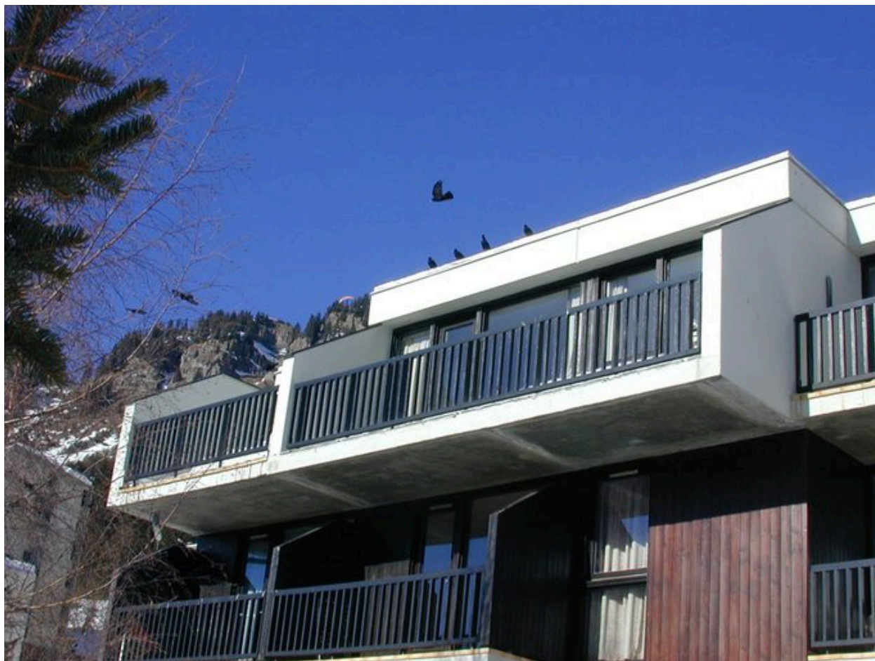
Les balcons de la façade sud
