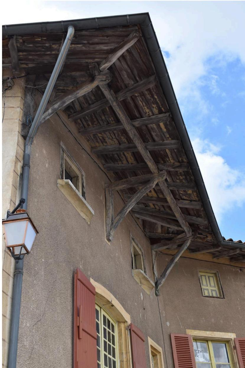
Elévation est de la maison, détail de l'avant-toit avec aisseliers.
