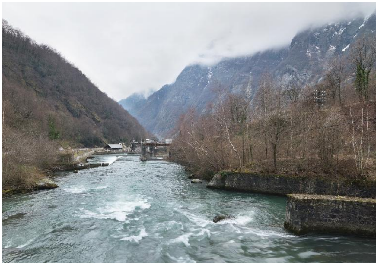
Vue du barrage de Livet
