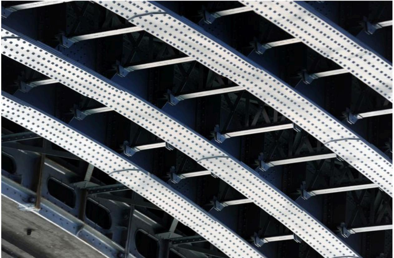
Arche, de dessous, vue de détail : jonction entre la structure métallique et le béton (depuis la rive gauche)
