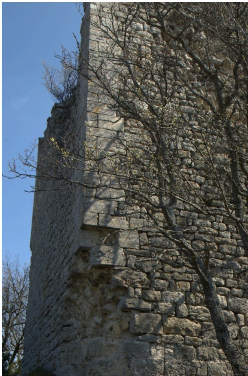
Angle sud-ouest, détail.
