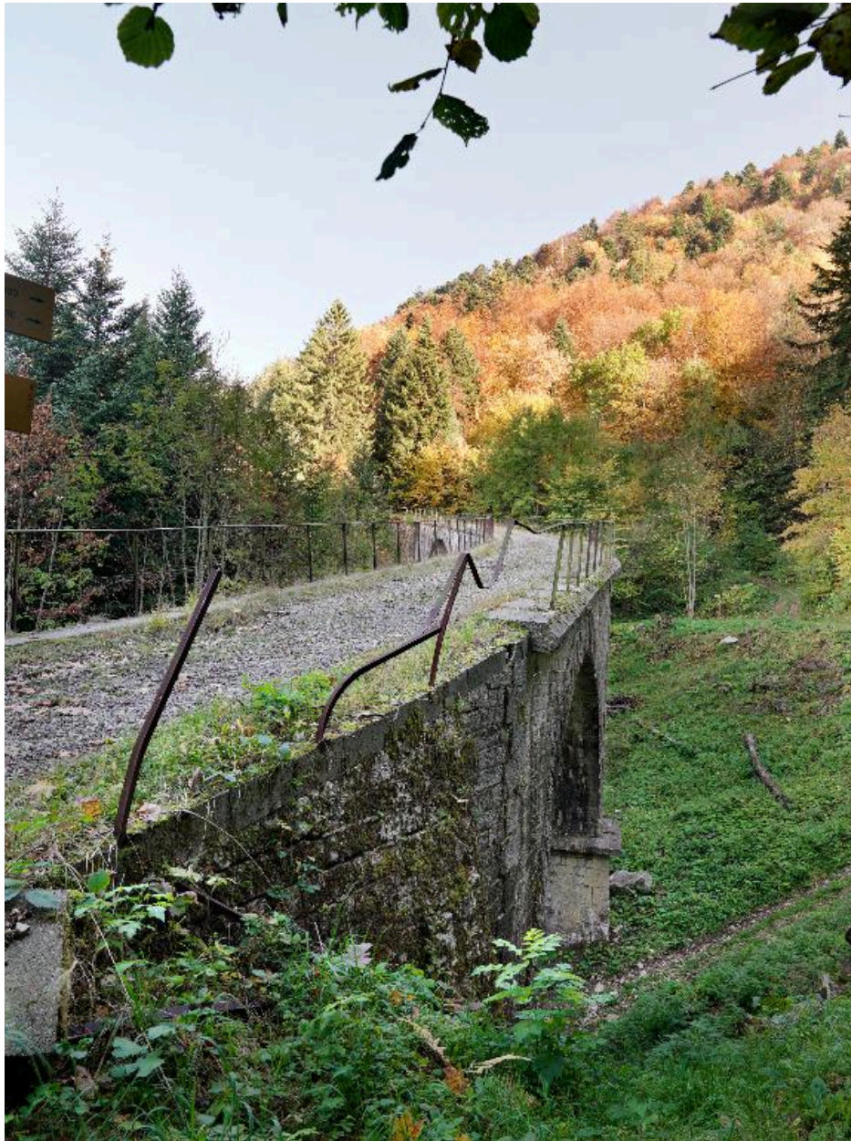
Viaduc des Fontanettes : tablier.
