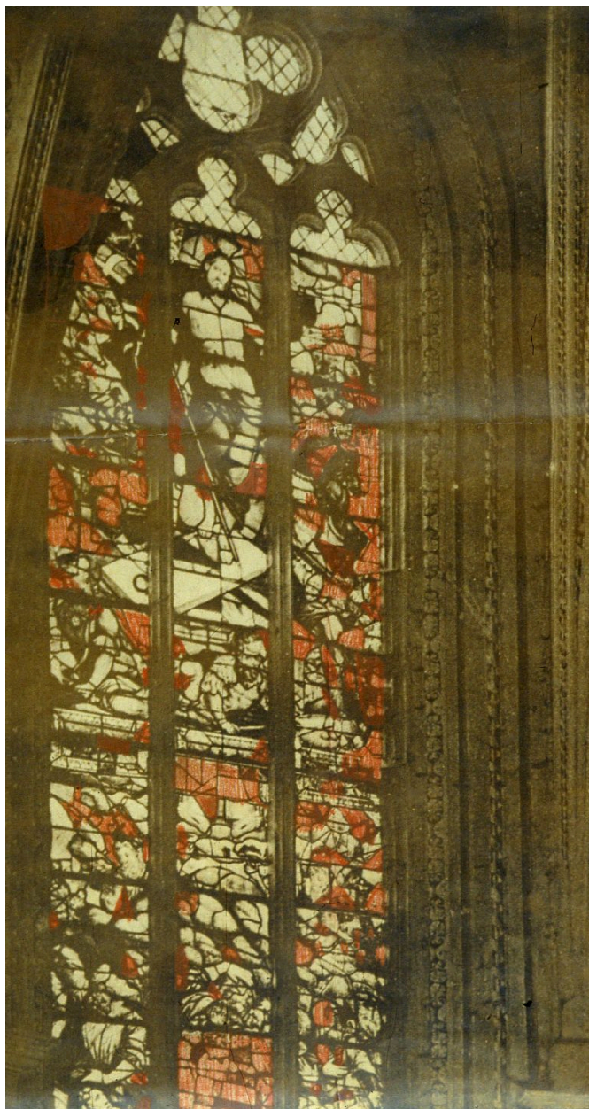
Baie 2 : photographie avec surcharge colorée indiquant les parties restaurées.
